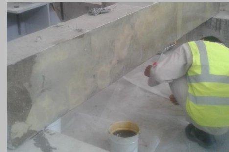
Primer coat application
